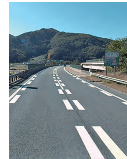
導流レーンマーク（破線部分）
