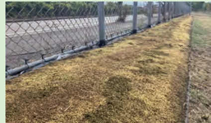
苔シート敷設の様子
