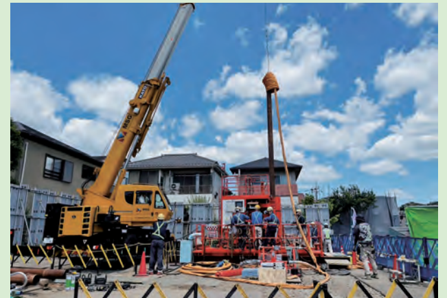
地盤補修の現場
