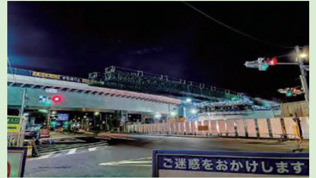
関越道 大泉JCT Cランプ第一橋
