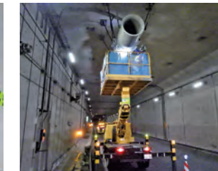
トンネル換気設備清掃
