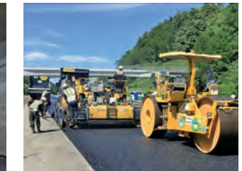
舗装補修作業
