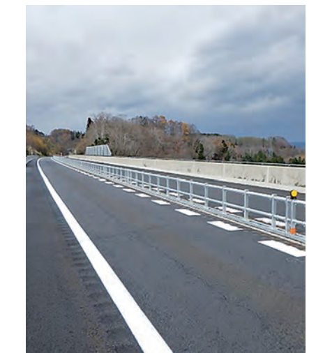
橋りょう部のセンターパイプ
