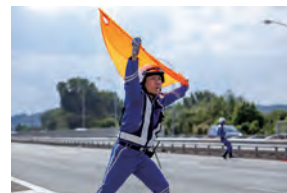
落下物排除の様子
