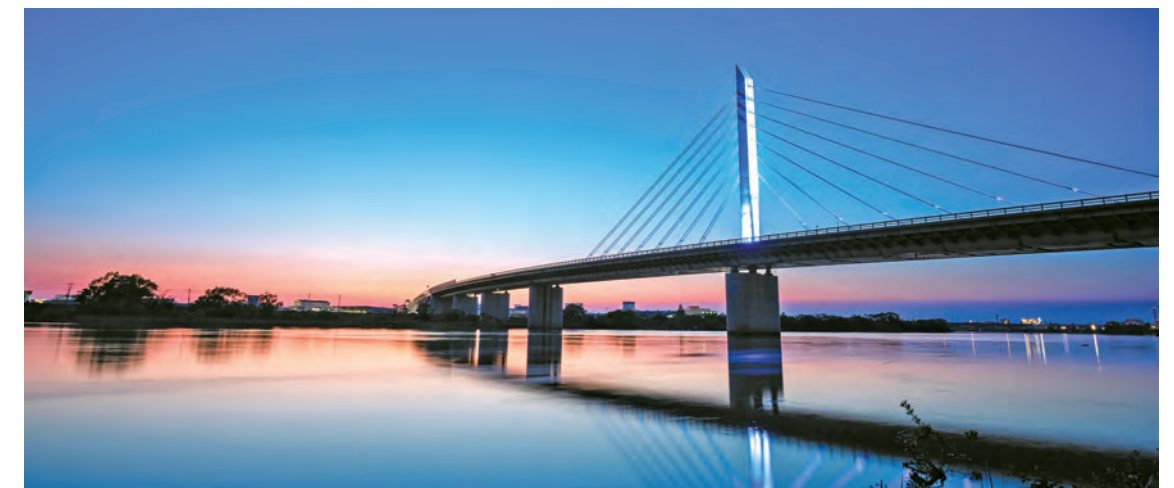
ときめき橋(橋の長さ: 372.6m) (北陸道 新潟西IC~新潟中央JCT間)
