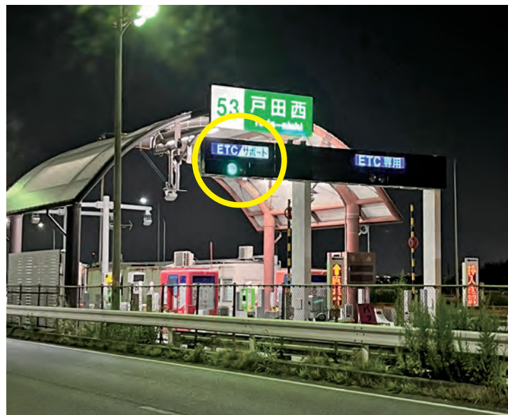
誤ってETCが使えない状態(ETC車載器未設置、ETCカード未挿入等)でご利用された場合に通行いただく「サポートレーン」を設置しています。「サポートレーン」は、「ETC/サポート」または「サポート」と表示しています(円内)。(東京外環道 戸田西IC)
