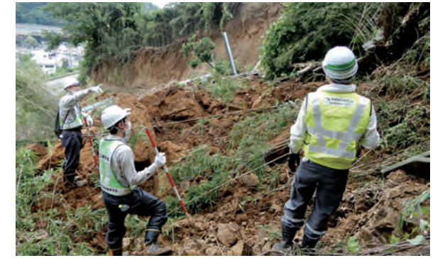
専門技術者による現場復旧支援
