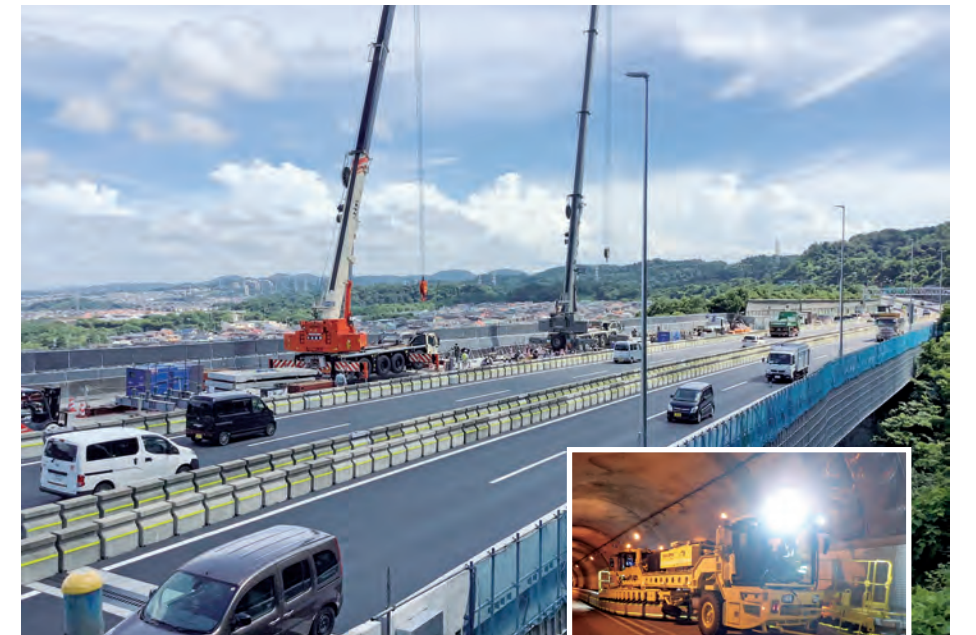
床版取替工事（横浜横須賀道路 釜利谷第二高架橋）
